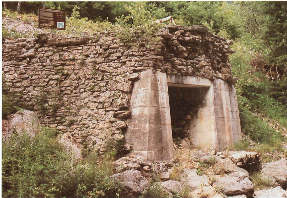
Un ouvrage en béton armé soutient la culée côté Villeneuve; au premier plan, des enrochements préviennent l'affouillement de la culée (Photo: A. Jacques)
