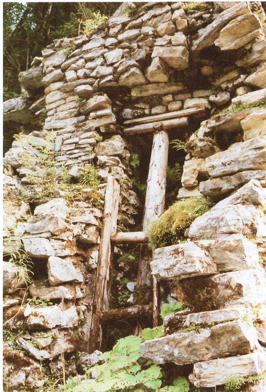
Culée côté Corbeyrier: l'intérieur actuellement occupé par la poutraison était rempli de terre glaise pour en assurer l'imperméabilité
