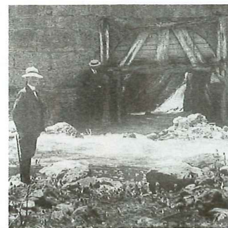
Culée côté Corbeyrier: l'intérieur actuellement occupé par la poutraison était rempli de terre glaise pour en assurer l'imperméabilité
