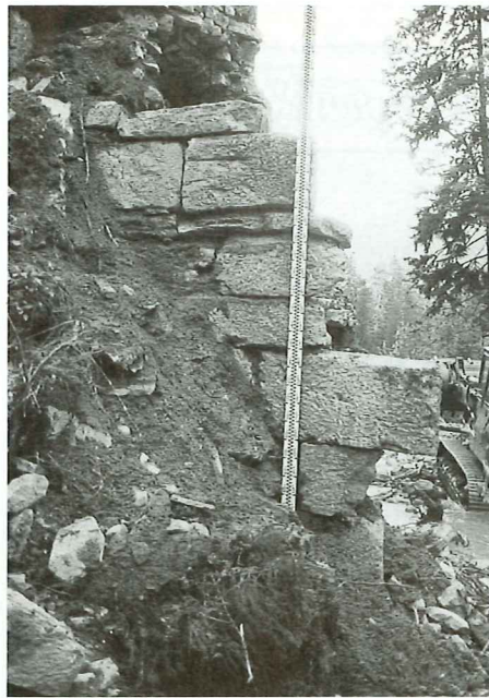
Un ouvrage en béton armé soutient la culée côté Villeneuve; au premier plan, des enrochements préviennent l'affouillement de la culée (Photo: A. Jacques)
