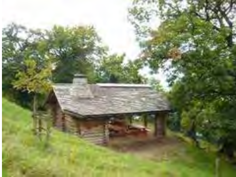
Le refuge de Champbabau, sur les hauts de Veytaux, est construit intégralement en bois de châtaignier © J. Pellet
